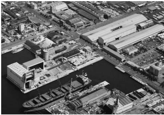
本社工場（右上部）、新運転工場（左側）の全景
