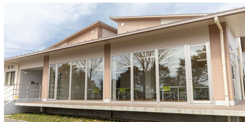
「白浜町第２ⅠＴビジネスオフィス」。町の公園管理事務所を建て替え（事業費２.１億円、オフィスは４室）
