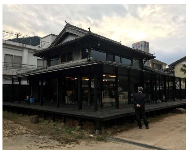
写真Ⅳ-9 えんがわオフィス
